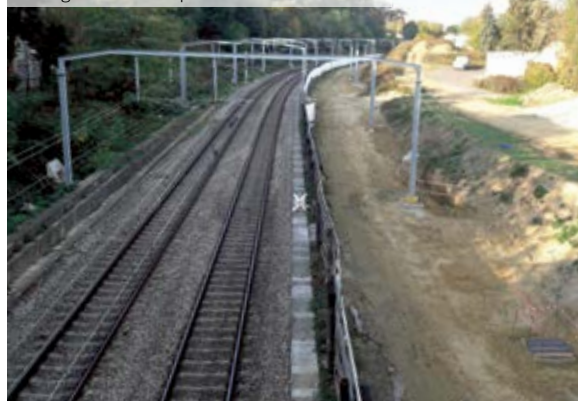
Nouveaux portiques à Orsay - Ville pour s'adapter à l'élargissement de la plateforme ferroviaire
