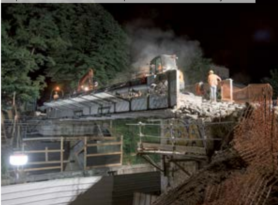
Le pont du Grand Mesnil a été déposé dans la nuit du 2 au 3 juin 2018
